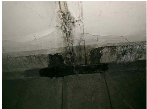
NATM구간 측벽부 S302 균열( C_w=0.2\text{mm} )
