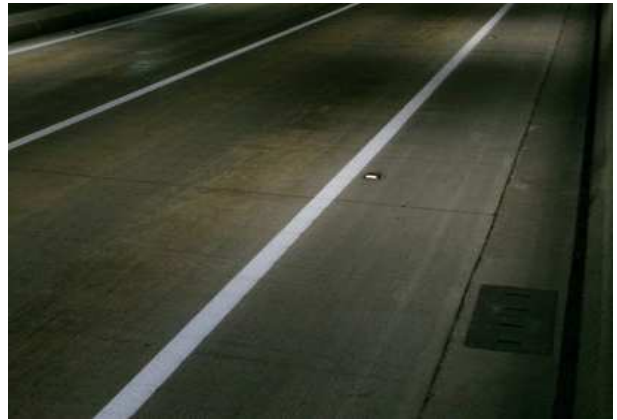
배수시설 단면변화부 배수덮개 상태양호
