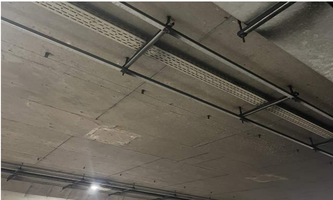
BOX구간 슬래브 전경
