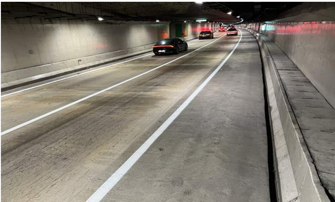
BOX구간 포장 전경
