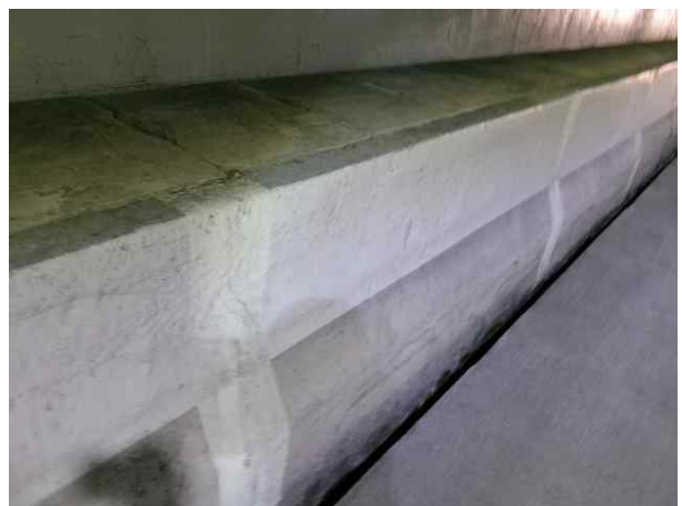
공동구 균열보수 양호
