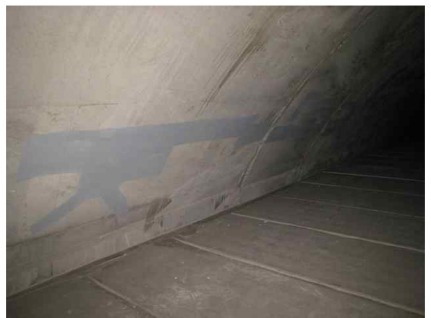
NATM구간 천정부 굽힘보수 양호
