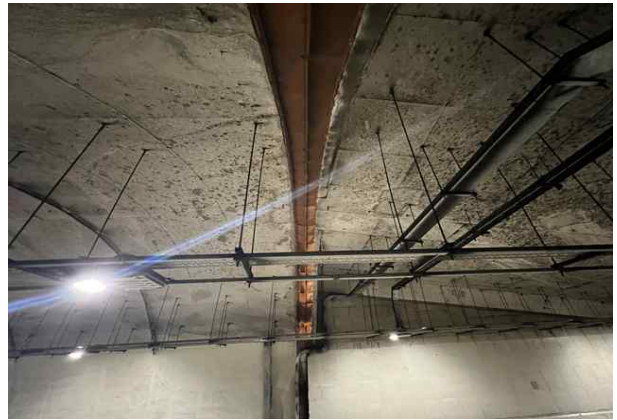
배수시설 단면변화부 배수덮개 상태양호
