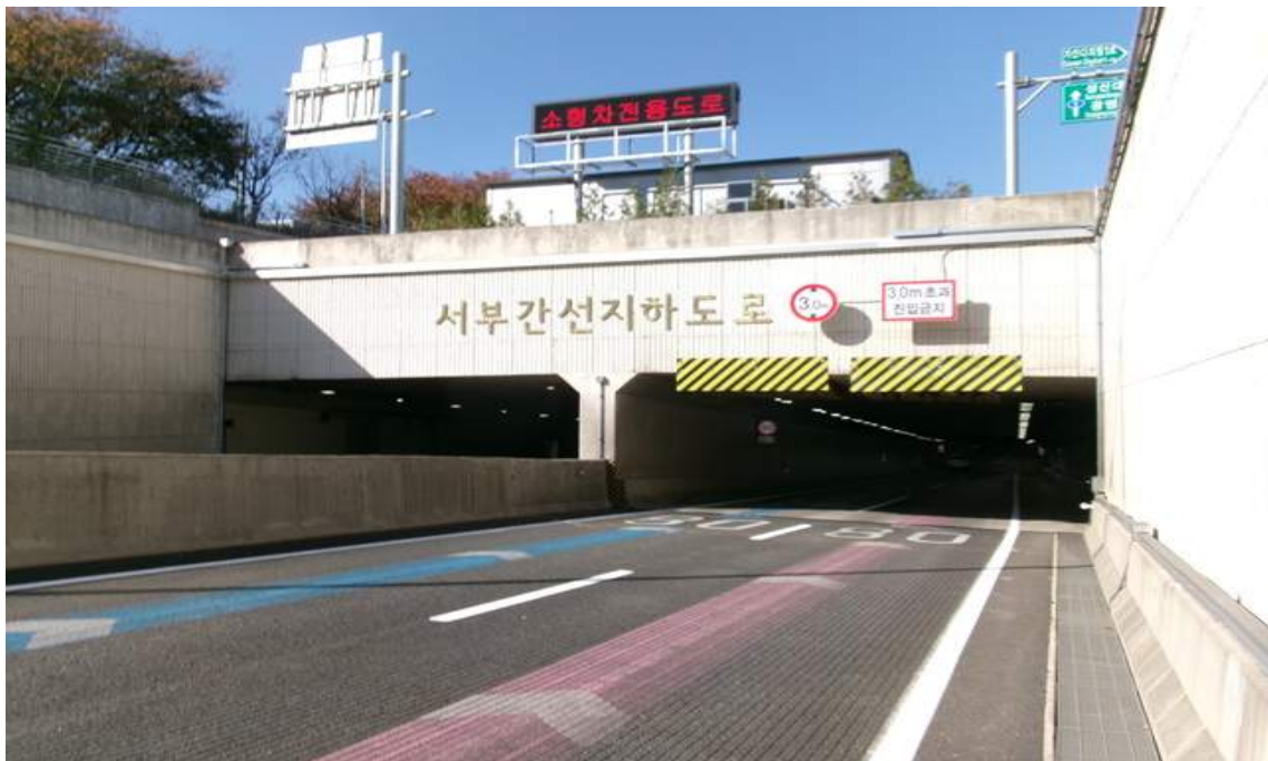
성산방향 갭문 종점부 전경
