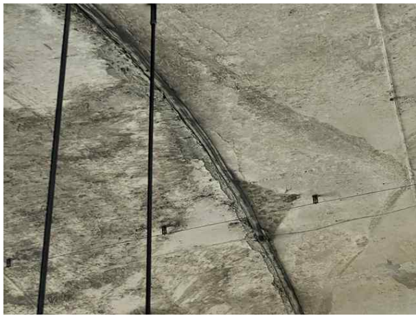
NATM구간 천정부 S003 반원형균열( C_w=0.2\text{mm} )
