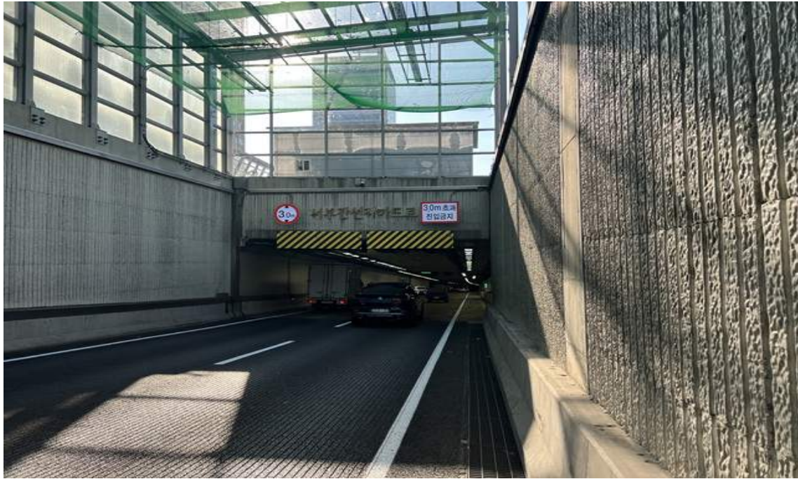
일직방향 갭문 시점부 전경
