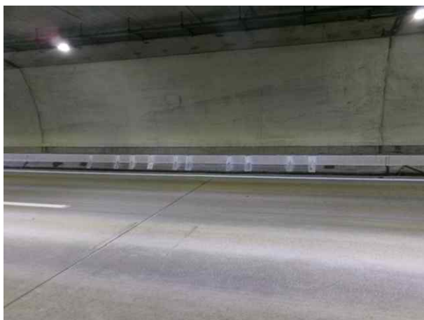
공동구 균열보수 양호
