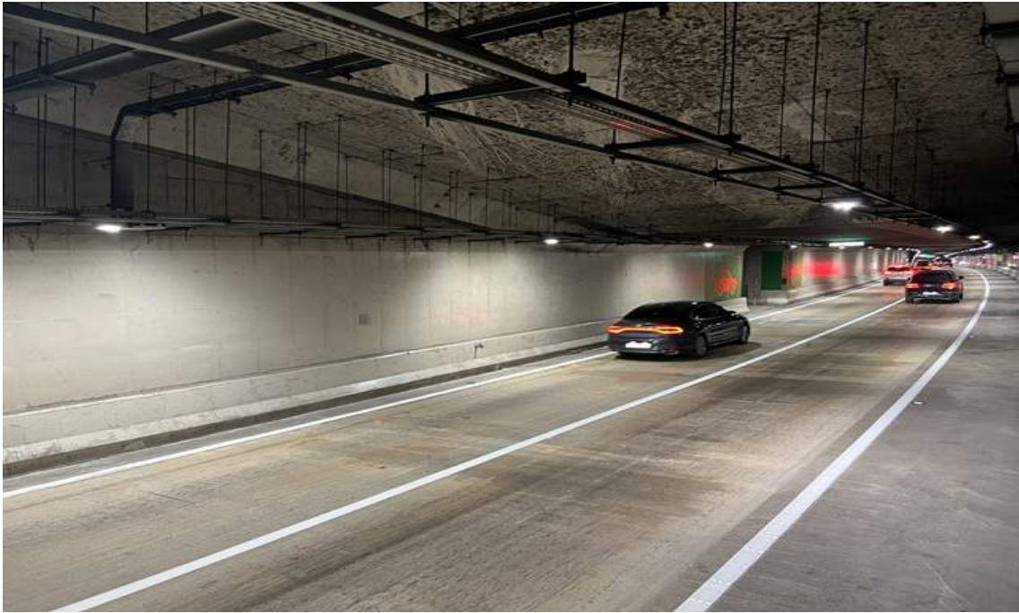
BOX구간 벽체 전경
