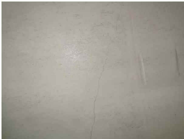
NATM구간 측벽부 S302 균열( C_w=0.2\text{mm} )
