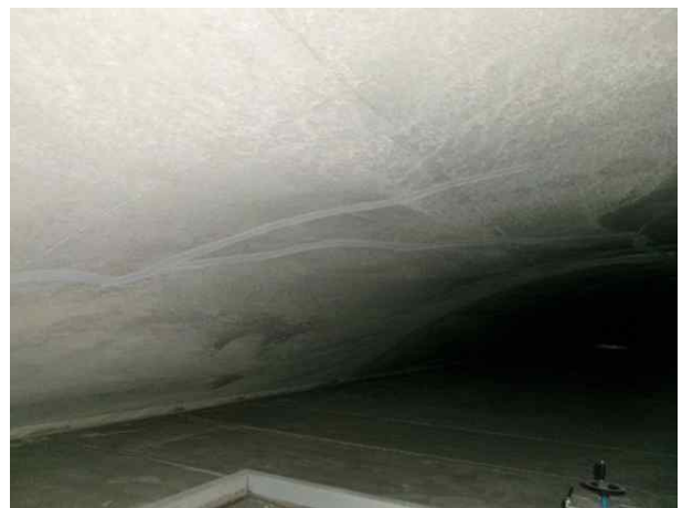
NATM구간 천정부 균열보수 양호
