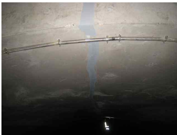
NATM구간 천정부 균열보수 양호
