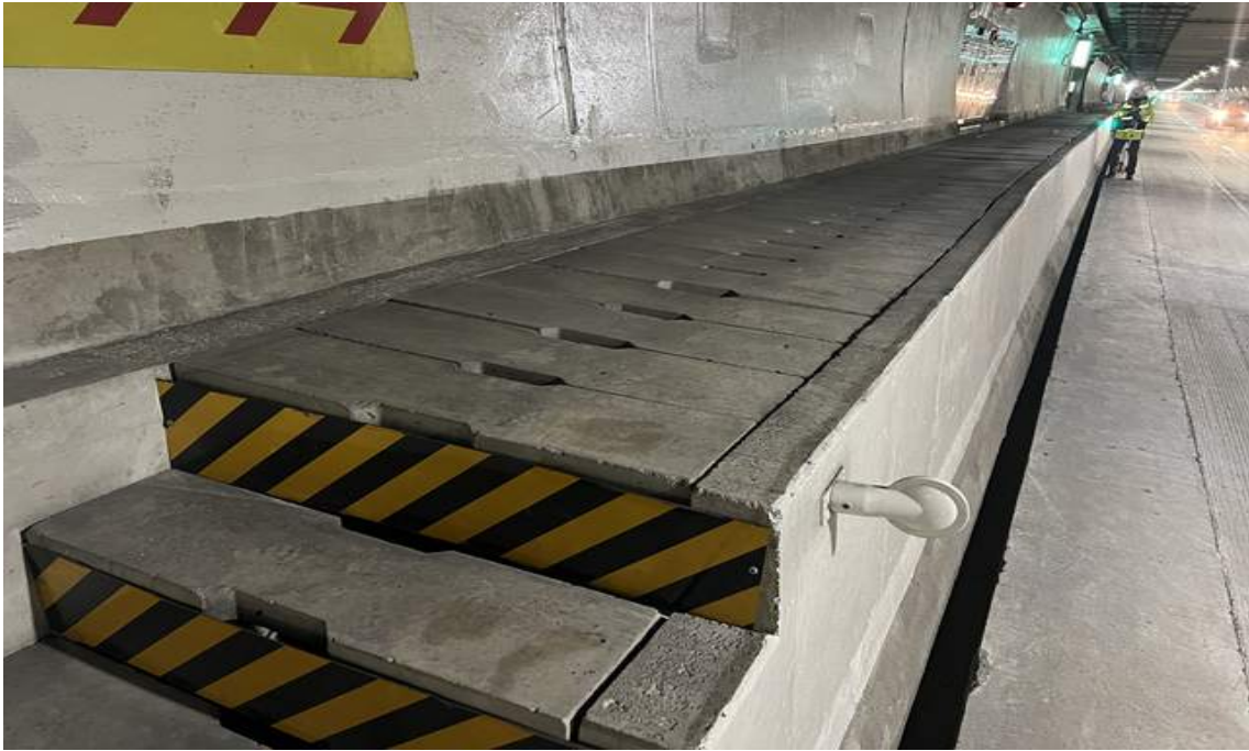
NATM구간 공동구 전경
