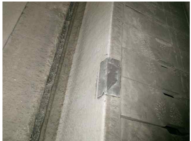
공동구 본체파손 보수 양호
