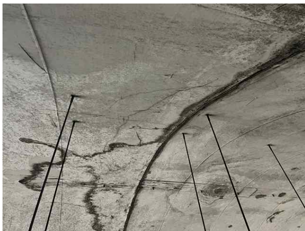
NATM구간 천정부 S032 반원형균열( C_w=0.5\text{mm} )
