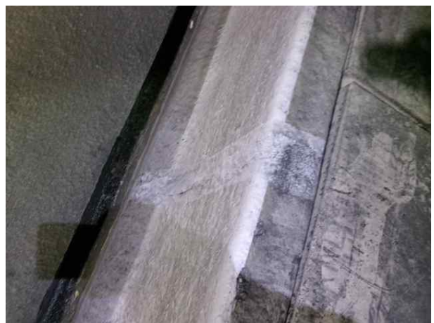
공동구 균열보수 양호
