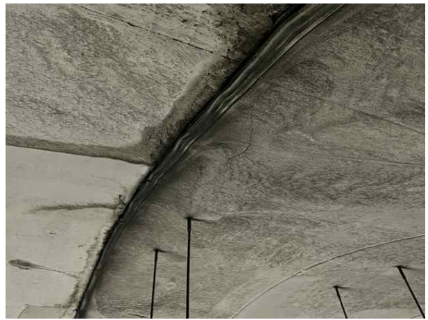
NATM구간 천정부 S024 반원형균열( C_w=0.3\text{mm} )
